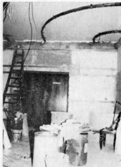
Hala v průběhu rekonstrukce
