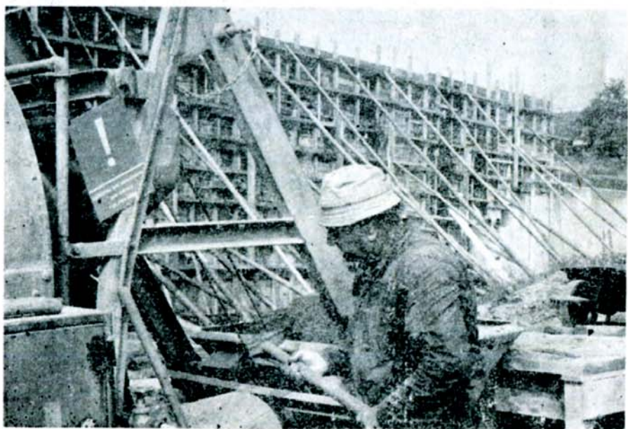
Částečný pohled na monumentalitu stavby nového koupaliště. Josef Štěpnička při opravě násypníku mičačky betonu
