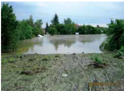
25. 5. Polder v Tyršově ulici
