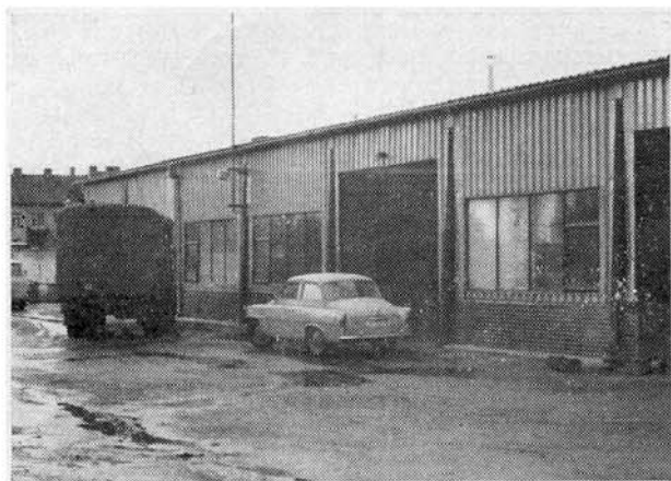
Provozní objekt JmVAK
