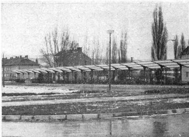
Výstavba autobusového nádraží v ul. Čs. armády
