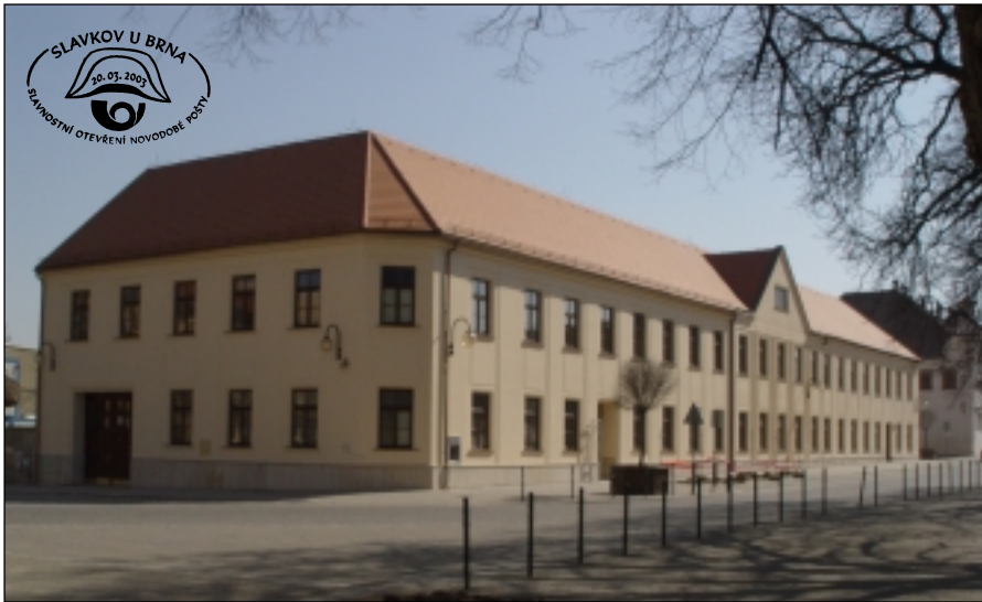
Novotou září opravená budovy pošty.
